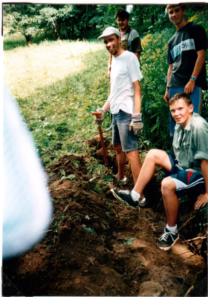
Kopání potrubí a upevňování šachty na zachycování vody
